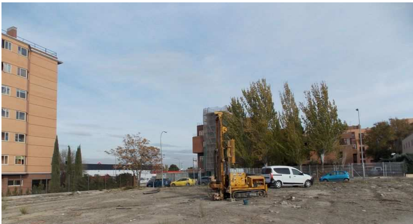
FOTOGRAFIA 7: Vista de la perforación del sondeo 4.
